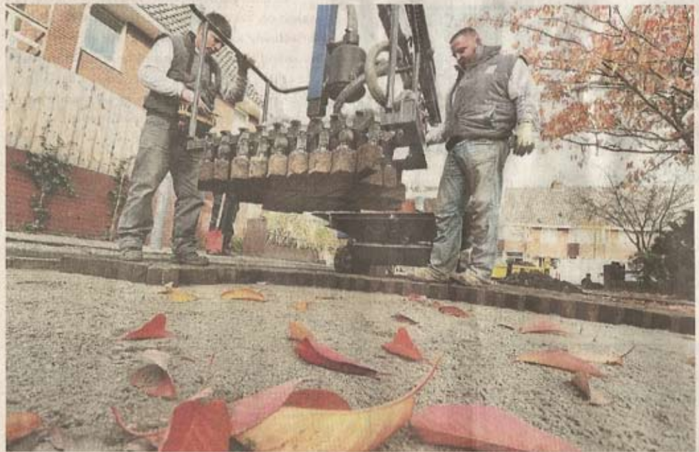
De bestrating van de Frans Halsstraat vordert gestaag met Street Designer.
